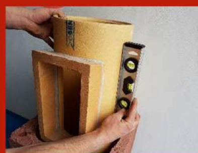
Fig. 8. Verificare cu nivela
