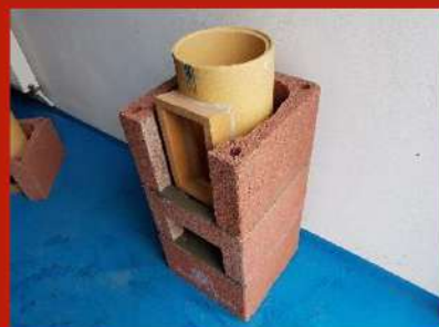
Fig. 9. Așezare manta
