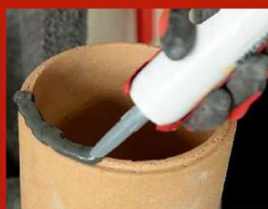
Fig. 7. Aplicare silicon
