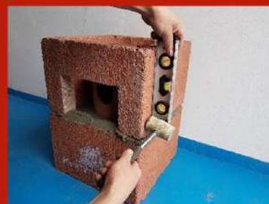
Fig. 4. Așezare manta
